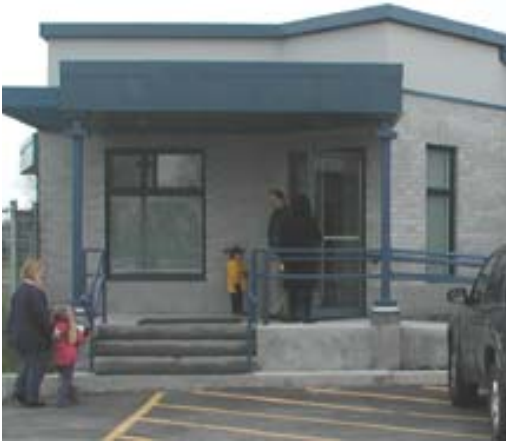
Le nouveau bâtiment du Centre de la petite enfance André-Laurendeau
